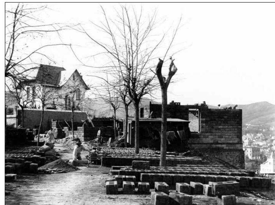
La casa Altimis en construcció amb els blocs de formigó, al carrer de Pedrell
